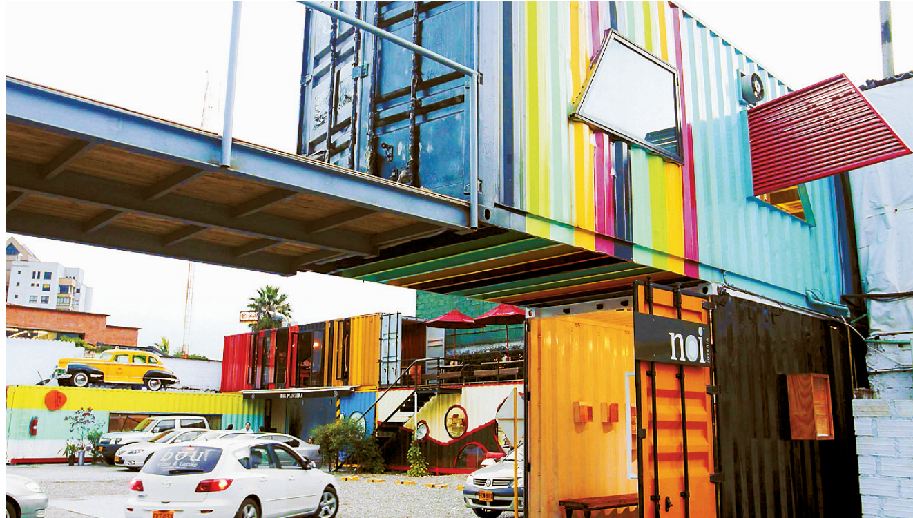
En Zona Libre utilizan contenedores High Cube, con una altura especial de 2,75 metros. Allí es posible ver las múltiples intervenciones en puertas, ventanas, ubicación y pintura que se les pueden hacer a los contenedores. Mucho color.
