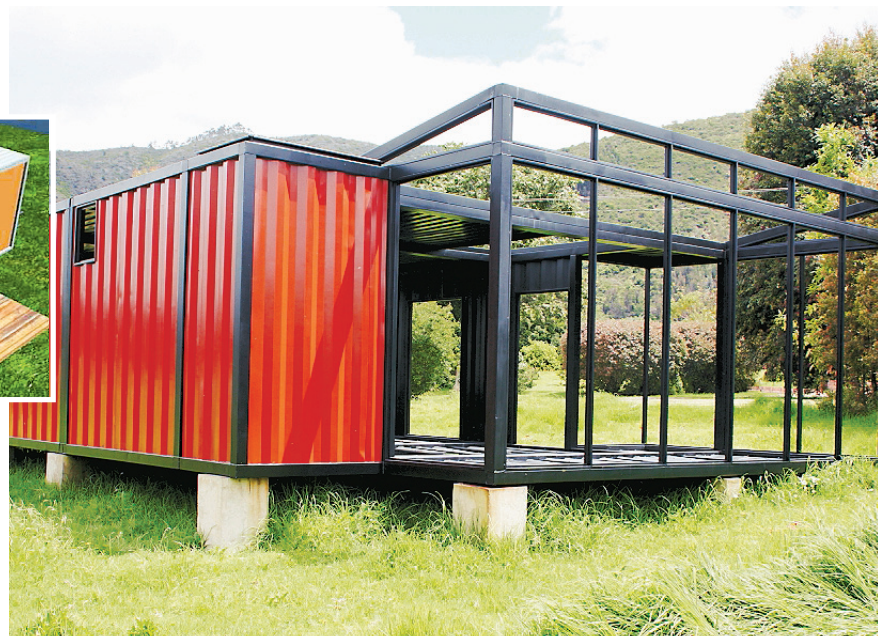
Aquí, la proyección virtual y la imagen real de una de las viviendas que se desarrolla en Cota, Cundinamarca, en la que se aplica la idea de arquitectura basada en contenedores.
