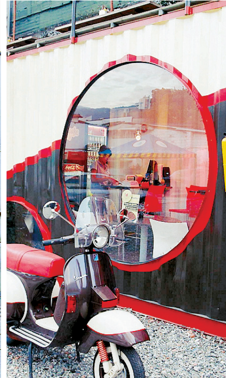
En Zona Libre utilizan contenedores High Cube, con una altura especial de 2,75 metros. Allí es posible ver las múltiples intervenciones en puertas, ventanas, ubicación y pintura que se les pueden hacer a los contenedores. Mucho color.
