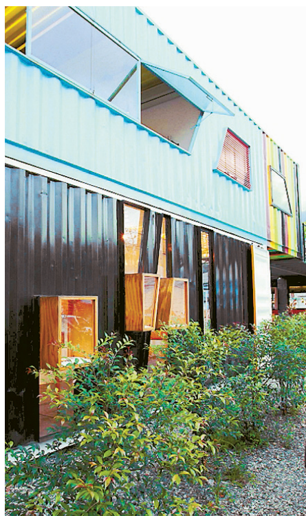
En Zona Libre utilizan contenedores High Cube, con una altura especial de 2,75 metros. Allí es posible ver las múltiples intervenciones en puertas, ventanas, ubicación y pintura que se les pueden hacer a los contenedores. Mucho color.
